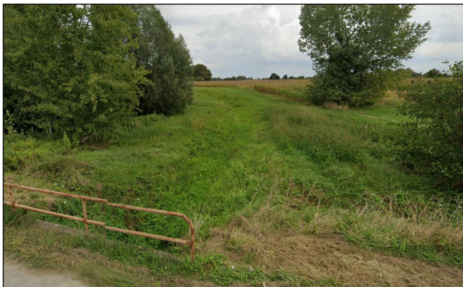
Slika 4.1.5-4. Pogled na kanal Vratnec istočno od trase LC 26001
